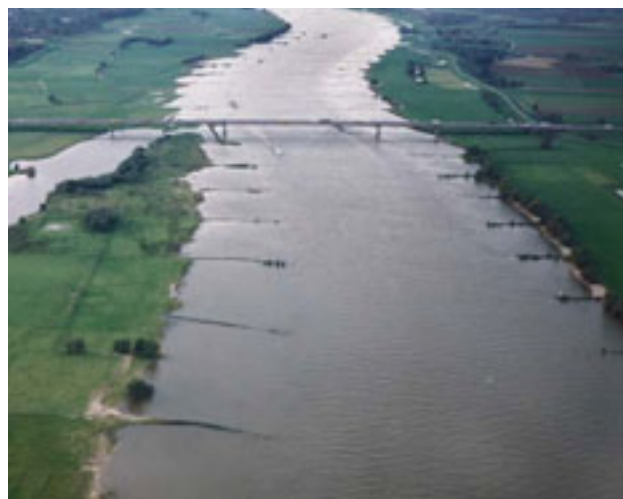
2 - DE NORMALISATIE VAN DE WAAL. DE NOORDELIJKE HELFT VAN DE PLAAT BIJ EWIIJK, HIER LOENENSE WEL GENOEMD, ZAL WORDEN AFGEGRAVEN. DE ZUIDELIJKE RIVIERARM WORDT DOOR EEN DAM AFGESLOTEN, EN ER WORDEN NIEUWE KRIBBEN AANGELEGD. RIVIERKAART VAN DE WAAL, 1870. HIER WERD DE WAAL GEFIXEERD IN DE GEDAANTE DIE DE RIVIER NU NOG HEEFT.
